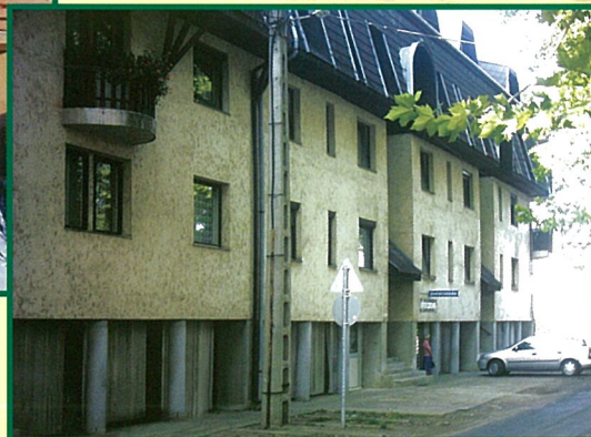
Fokozott hőszigetelésű, FABETON falazóelemekből készült épületek
