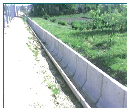
Támfalas árokburkoló Martonvásár
